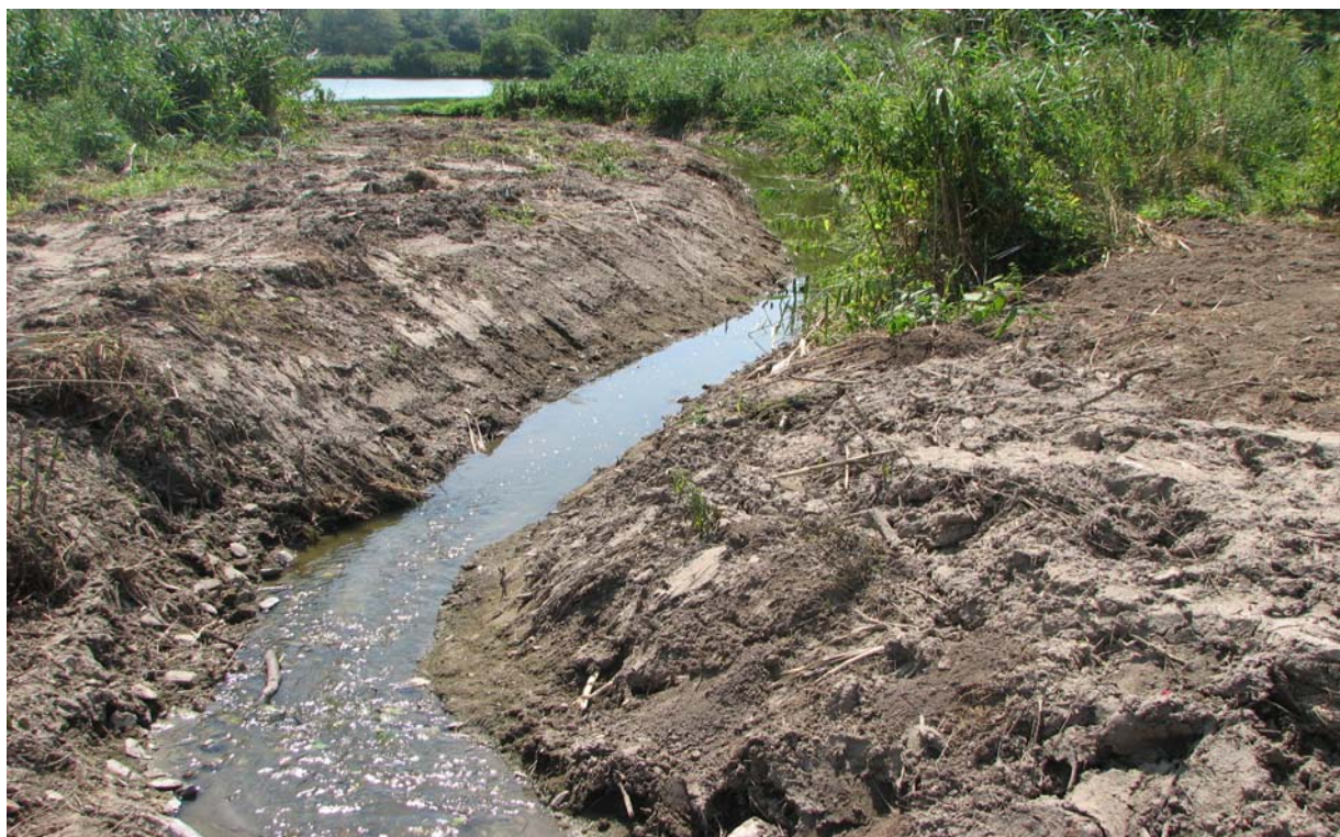
Upravený přítok do nádrže Pod Santonem
